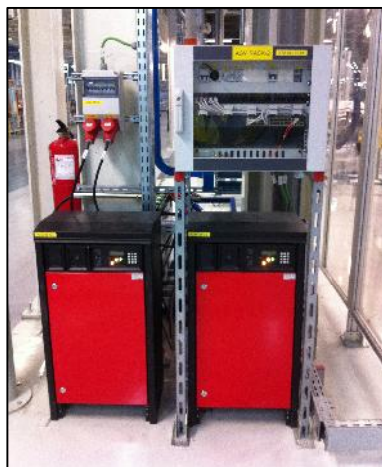
Cargadores Alta Frecuencia para recarga automática de baterías de Ni-Cd
